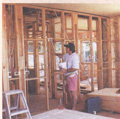
Клей наносят на стойку с шагом 300 мм.
